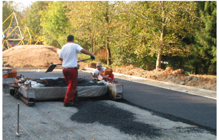
2. Einbau elastische Tragschicht
